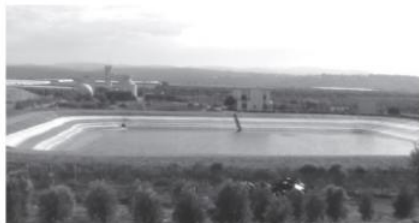
Hình 7.9a. Nhà máy xử lý nước thải sinh hoạt và hồ chứa nước tưới tại Israel
