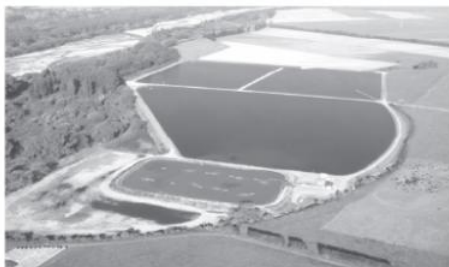
Hình 7.1. Xử lý nước thải bằng hồ sinh học 3 bậc
