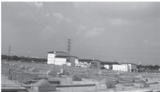
Hình 2.17. Quang cảnh nhà máy xử lý nước thải bằng hệ thống hồ sinh học Bình Hưng Hoà
