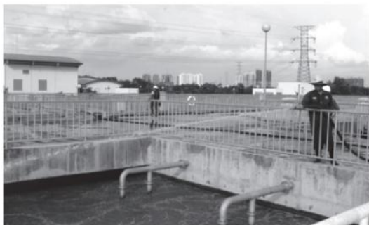
Hình 2.15. Nhà máy xử lý nước thải Bình Hưng
